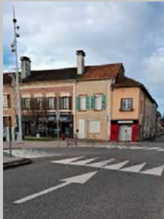
Marquages en résine, réalisés par l'entreprise BG Signalisation
